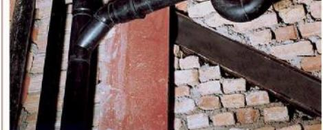
۶ در هنگام نصب و اجرا شیب لازم را برای مسیرهای نظر بگیرید و اتصالات و لوله‌ها را در مسیرهای افقی و عمودی با استفاده از بستهای مناسب ثابت کنید. لطفاً در صورت استفاده از دستگاه جوش به نکات مورد توصیه کارخانه سازنده توجه فرمایید.
